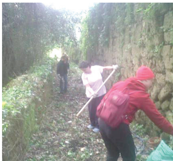
L'OASI VERDE Ponte di Mortora, parte l'opera di bonifica
