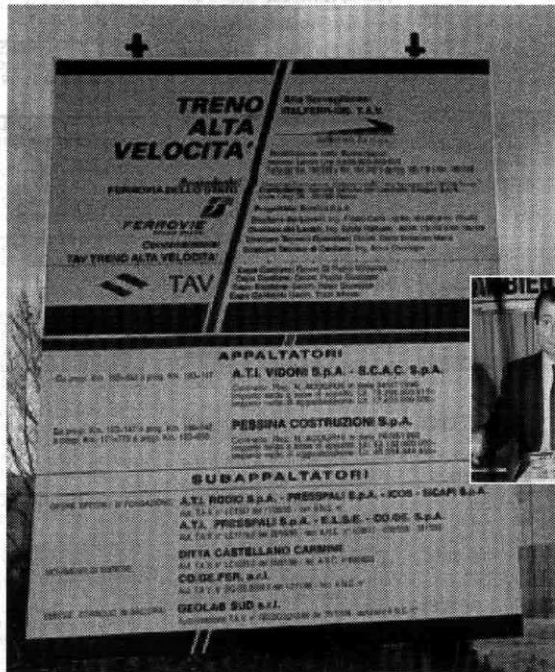
ALLA SBARRA Un cantiere della Tav. Sopra, Rocco Fusco. In basso, l'ex cronista del "Mattino" Pietro Funaro
