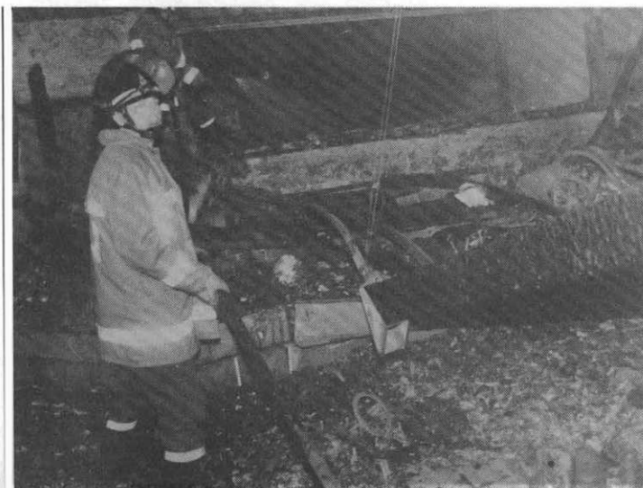
Un altro particolare dell'incendio al «Giordani»
